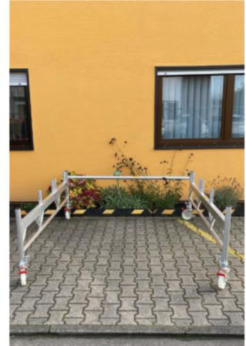
Ab dem **Gerüsttyp -05** müssen zwei **Ballastträger (2375)** angebracht werden.
