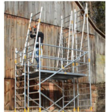
Stecken Sie anschließend den **Vertikalrahmen** auf und sichern diesen mit den unverlierbaren Federsteckern. Verfahren Sie mit dem zweiten **Vertikalrahmen** genauso.
