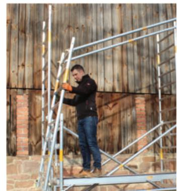
Der aufgesetzte **Vertikalrahmen** wird nun mit den **Montagelängsriegeln** verbunden und auf den darunterliegenden **Vertikalrahmen** aufgesteckt.
